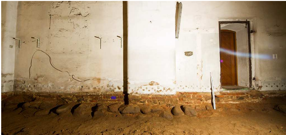
Ryc. 9- Ściana południowa nawy głównej - na niebiesko zaznaczone miejsce pobrania próbki do badań TL (6/Biała/2013)
