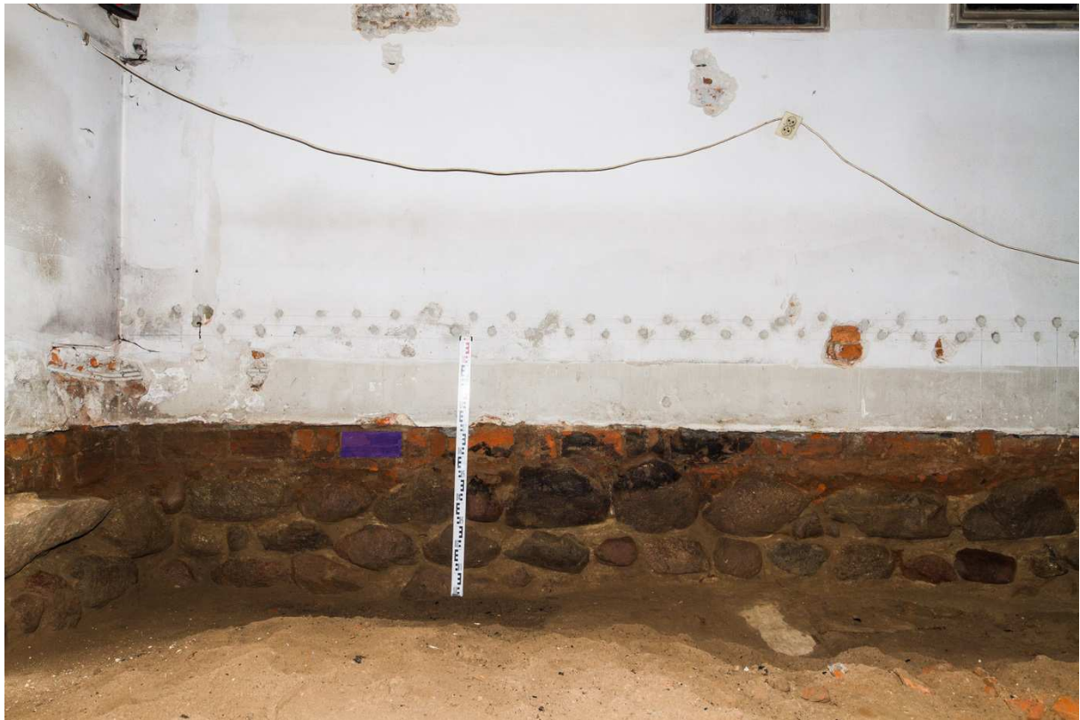
Ryc. 1 - Ściana północna prezbiterium - na niebiesko zaznaczone miejsce pobrania próbki do badań TL (5/Biała/2013)
